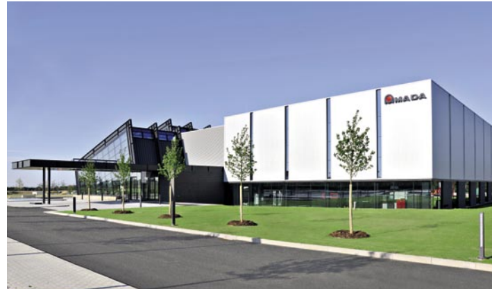
Die Customer Hall (linke Bildhälfte) und der angegliederte Show Room bilden die zentralen Bereiche im Solution Center.
