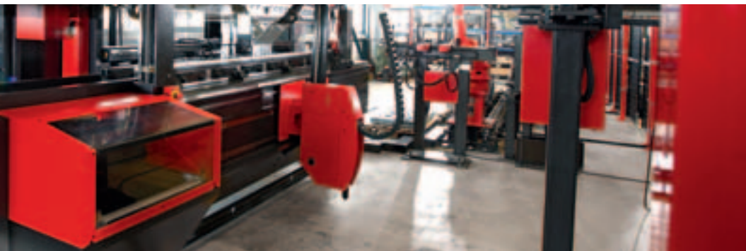
Ein automatisiertes Hochregallagersystem (ganz oben im Hintergrund) dient der Beschickung der Produktionszellen.
